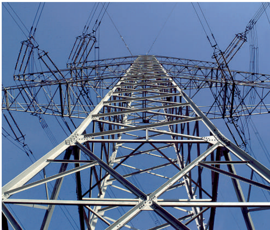
KWK-Anlagen können den Strom- oder den Wärmeertrag optimieren.
